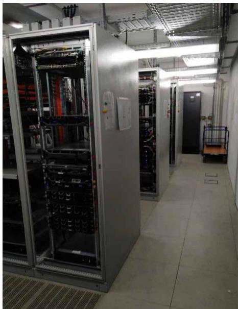
Abbildung 11: Serverraum des Grimm-Zentrums mit Lüftungsboden im Vordergrund
